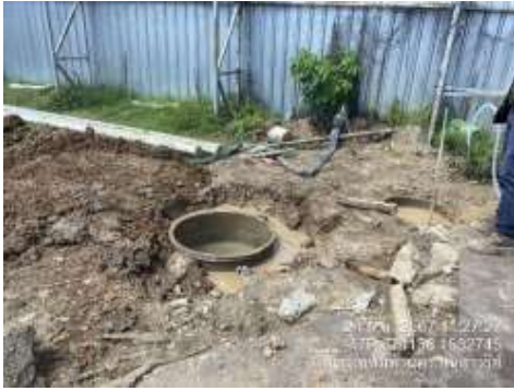
รูปที่ 4 ปอดักตะกอน
